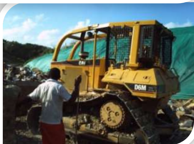
Maquinaria pesada para la operación
