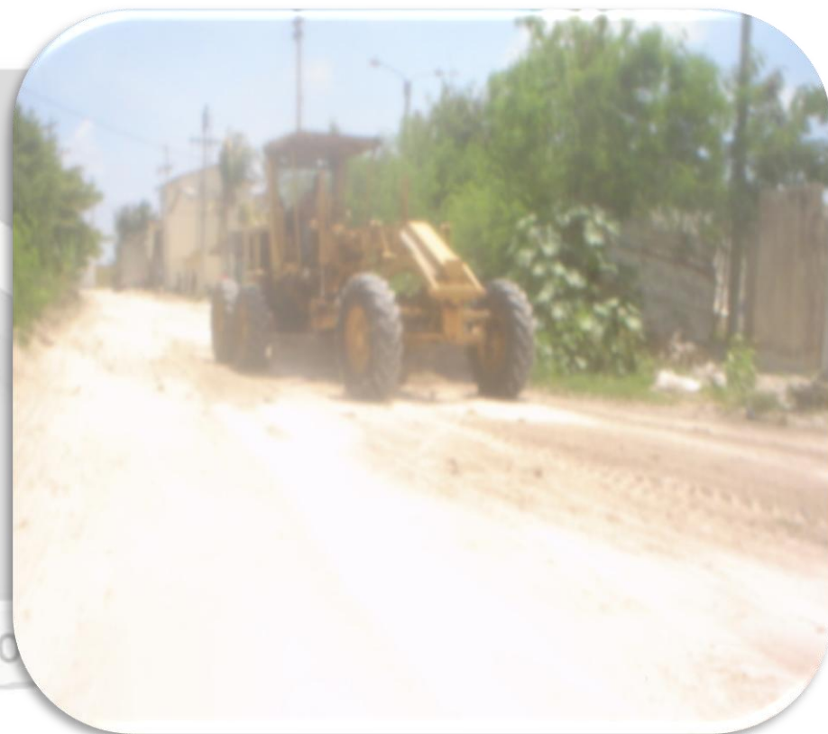
MANTENIMIENTO DE VIA DE ACCESO AL MUELLE DE GUARDACOSTAS
