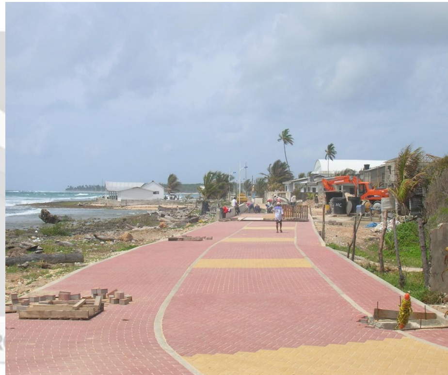
ESTADO ACTUAL VIA HACIA EL SUR
