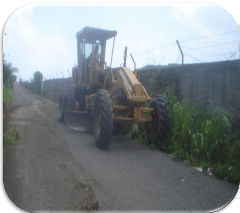
MANTENIMIENTO DE LA VIA TABLITAS
