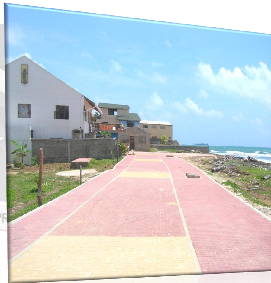
ESTADO ACTUAL VIA HACIA EL NORTE
