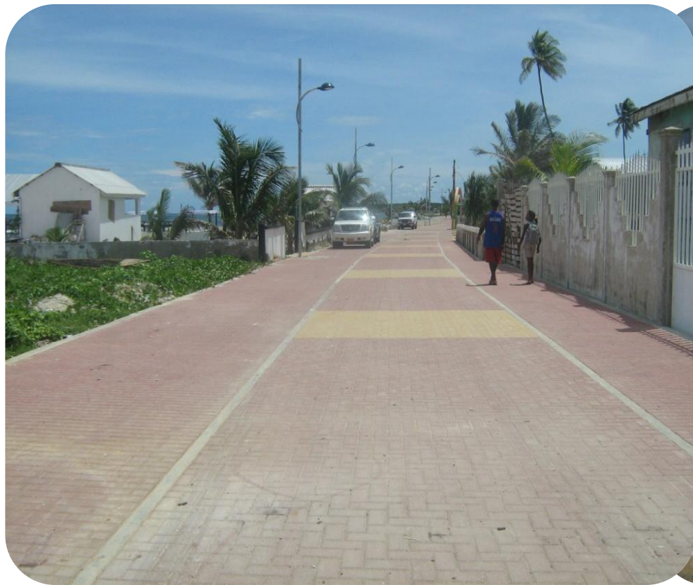
TRAMO FINAL AL NORTE
