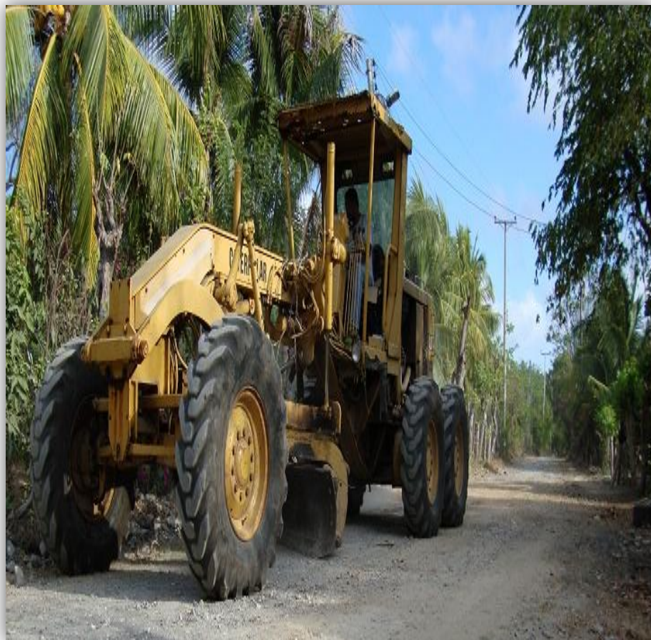
MANTENIMIENTO DE LA VIA FOUR CORNER
