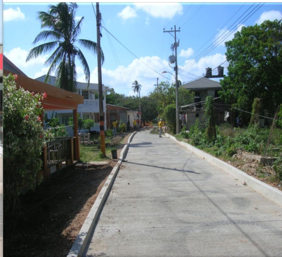
ESTADO ACTUAL VIA ACCESO TIENDA
