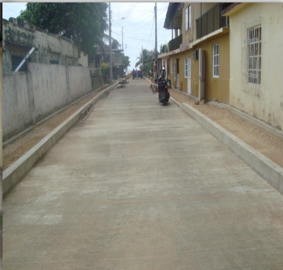
ESTADO ACTUAL VIA ACCESO RANCHO
