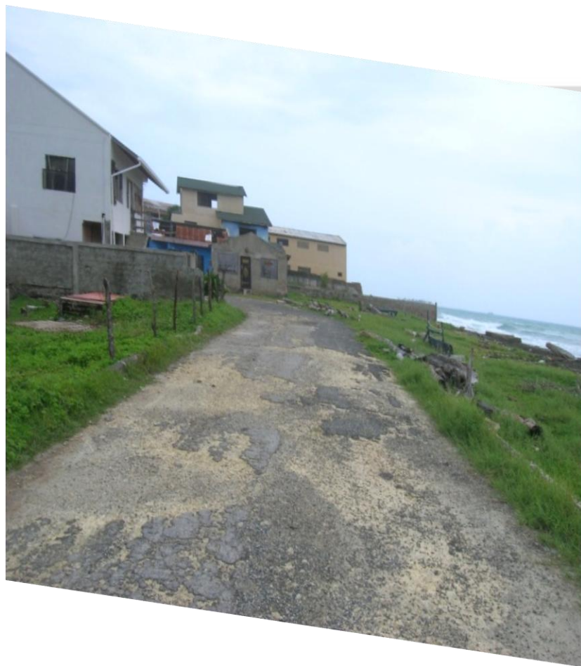
ESTADO ANTERIOR VIA HACIA EL NORTE
