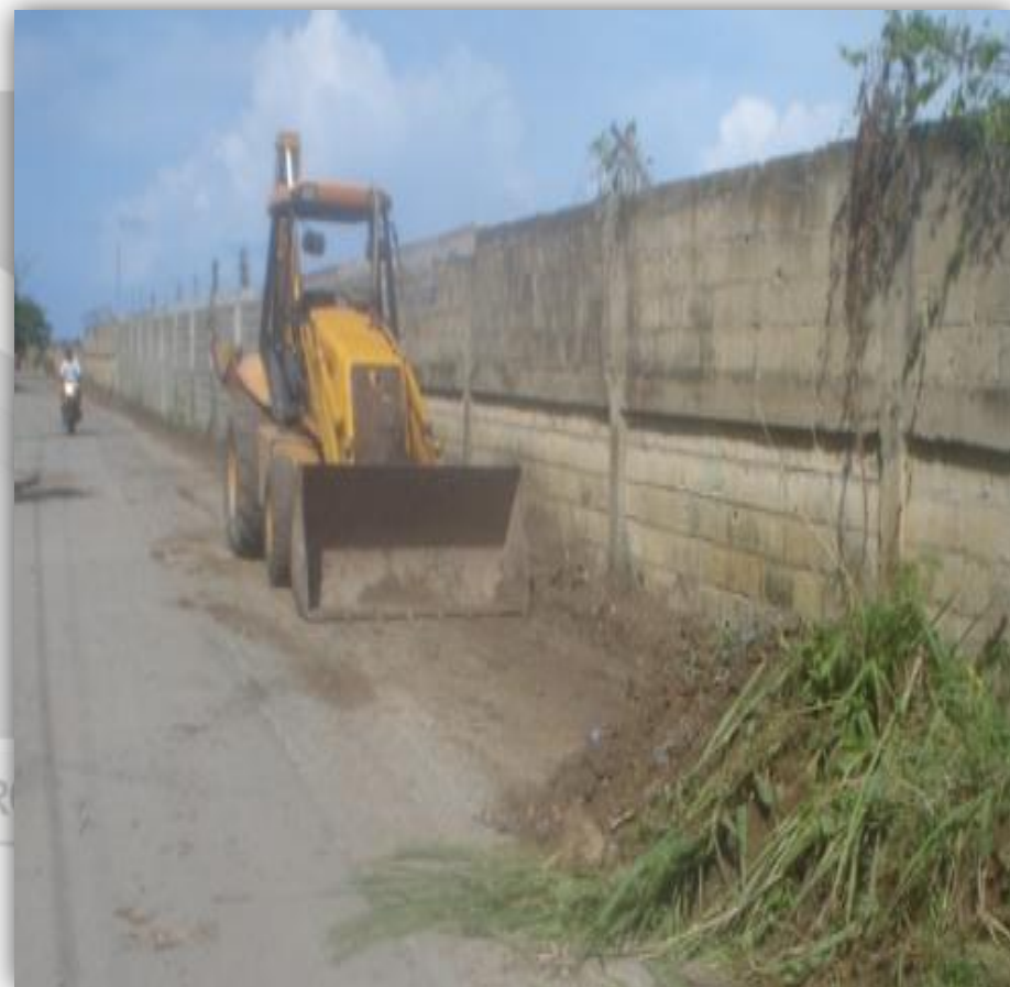
MANTENIMIENTO DE LA VIA LOX BIGHT
