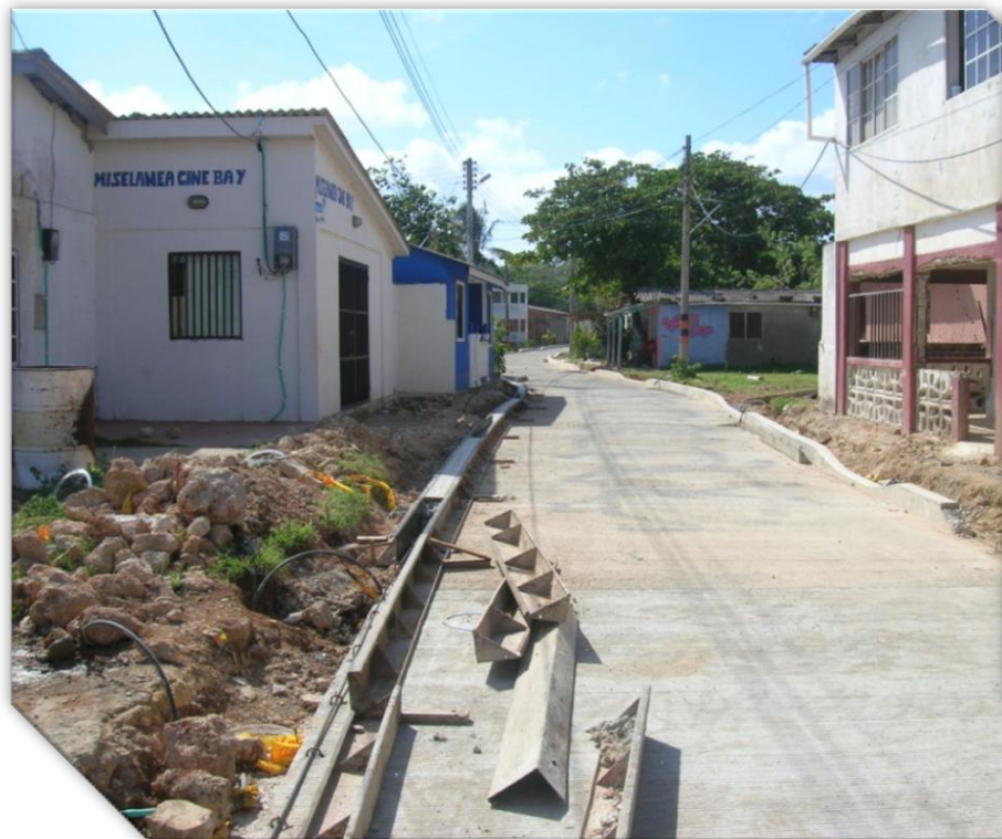
ESTADO VIA EN EJECUCION
