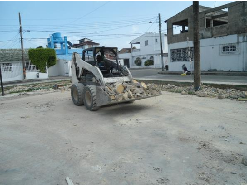
Obras parque Almendros
