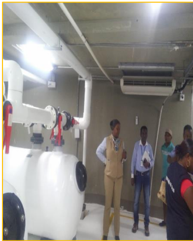
Foto 2. Inspección Hotel sol caribe
