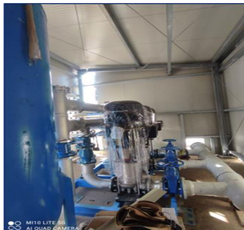
Imagen. Finalizó instalación de equipos de bombeo, equipos eléctricos y juegos de tuberías en la caseta de bombeo de la línea de impulsión, así como la instalación de la cubierta y paneles sándwich de la fachada.
