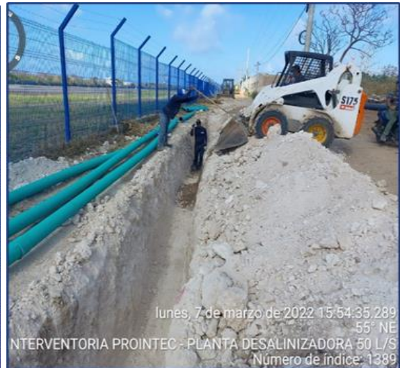
Imagen. Avance actividades de construcción de la acometida eléctrica de media tensión entre la Subestación de School House a la planta desalinizadora en Lox Bight.
