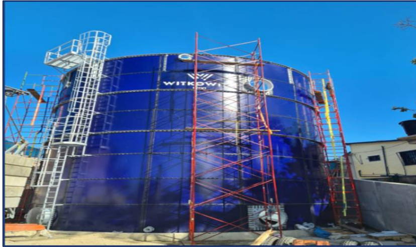
Imagen. Finalización de la instalación del octavo anillo del tanque prefabricado; los manhole, bridas y accesorios del tanque de almacenamiento
