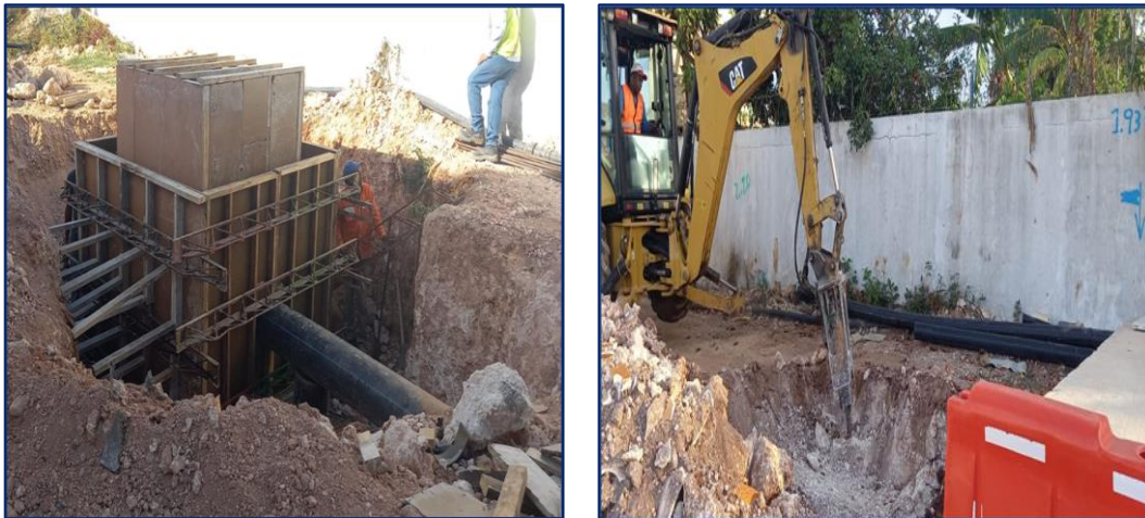
Imagen. Construcción de las dos cámaras de la línea de impulsión al interior de Lox Bight, con la ejecución de la excavación, y armado de hierros y encofrado
