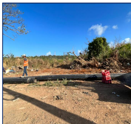
Imagen. Construcción Tubería de Aducción y Rechazo.
