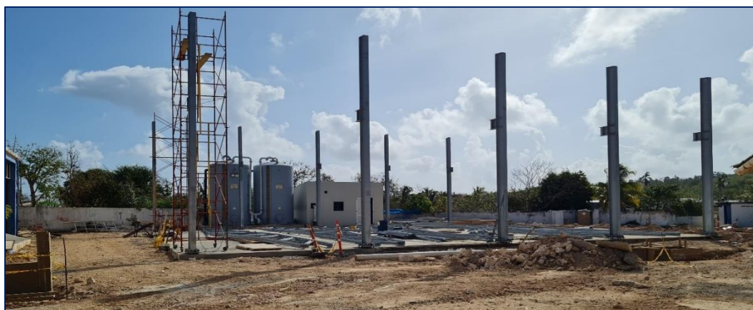
Imagen. Avances instalación de columnas para bóveda planta desalinizadora de 50 lps
