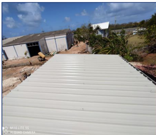
Imagen. Finalizó instalación de equipos de bombeo, equipos eléctricos y juegos de tuberías en la caseta de bombeo de la línea de impulsión, así como la instalación de la cubierta y paneles sándwich de la fachada.
