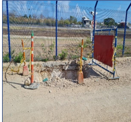
Imagen. Construcción cámaras de la línea de impulsión y relleno y compactación de área intervenida
