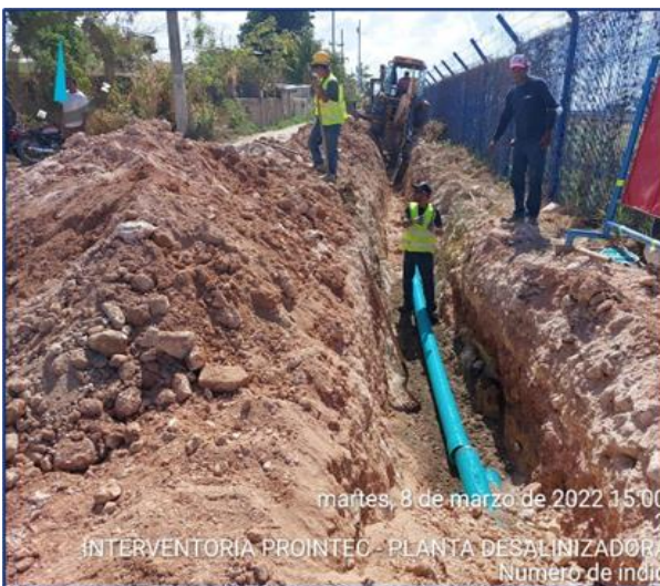
Imagen. Avance actividades de construcción de la acometida eléctrica de media tensión entre la Subestación de School House a la planta desalinizadora en Lox Bight.
