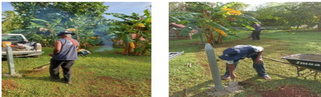
Figura 124. Actividades de limpieza, encerramiento y preparación del suelo
